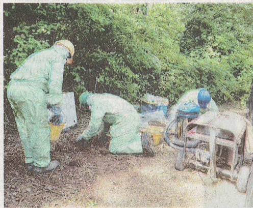
I carotaggi effettuati a suo tempo nei terreni contaminati
